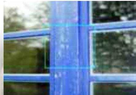
Lackabrisse durch Einsatz eines zu stark klebenden Gewebebandes. Empfehlung: tesa® UV-Oberflächenschutzband 4438
